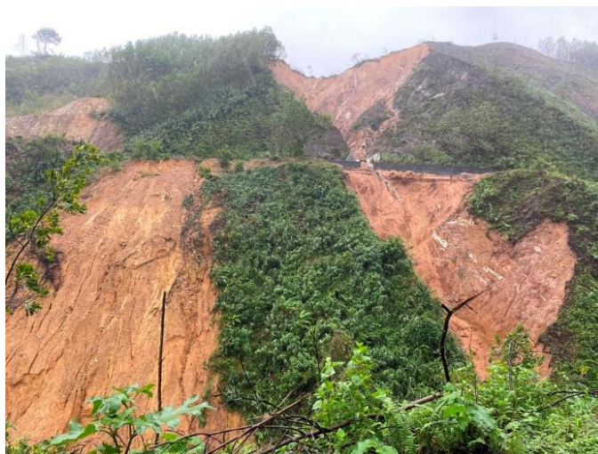
Hình 1. Điểm trượt đất mái dốc đoạn qua xã Hồng Hạ đến Bốt Đò (km 75 + 250 – km 75 + 350) trên Quốc lộ 49
