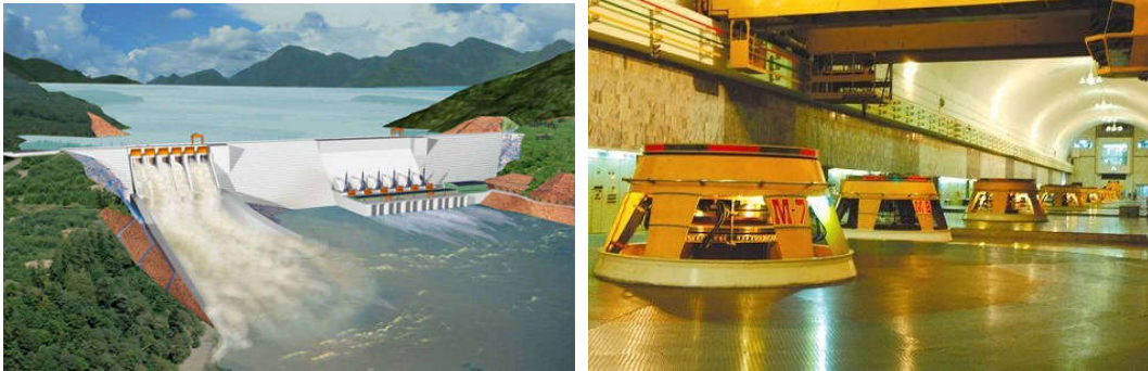
Hình 2. Đập và các tổ máy của nhà máy thủy điện
